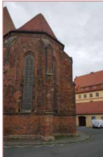
Die Stützpfeiler 6, 8, 9 und 10 werden 2023 saniert.
